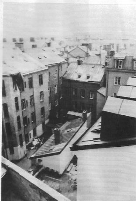
Gårdarna till husen Björngårdsgatan 9a och Bellmansgatan 38 sedda från trapphuset Fredmansgatan 11.
